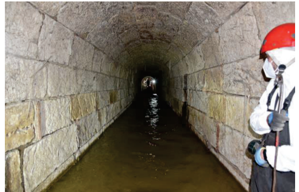
Fig. 2. Stone masonry sewer underground Rua da Prata.
